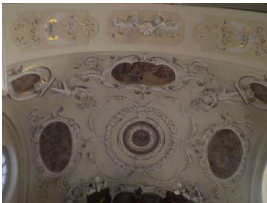
Sklepienie stiukowe nad Prezbiterium
