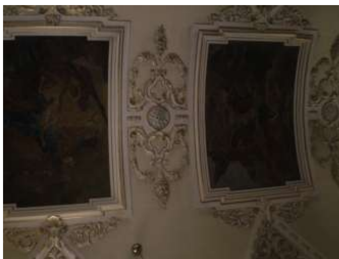
Sklepienie w nawie głównej
