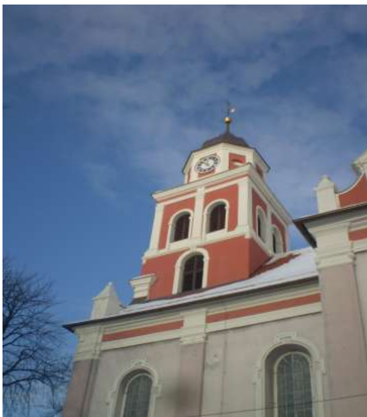
Wieża kościelna po remoncie
